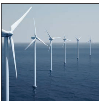
Centrali eoliche per la produzione di energia
